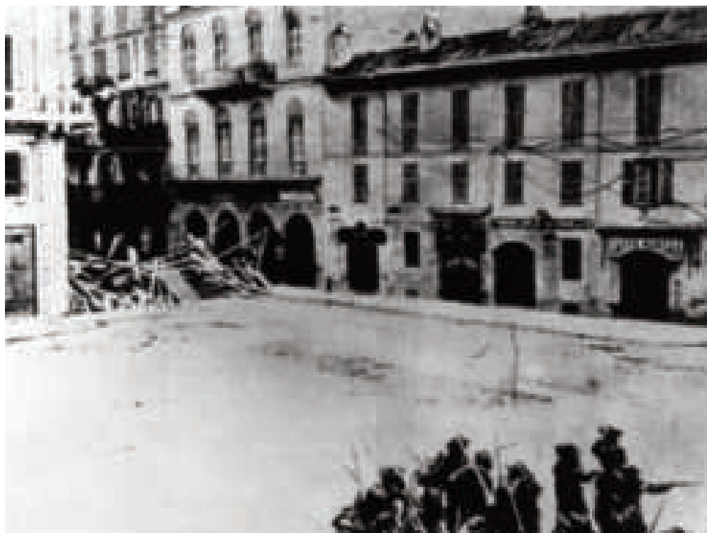
■ Nella foto: Barricate dei rivoltosi ed intervento dei bersaglieri, Milano 1898, foto di Luca Comerio
